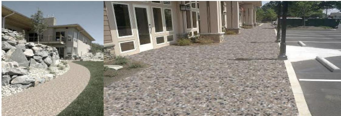
**2.4.1. Definitie:** In betonul cu agregate expuse, agregatele (pietrele) cele mai apropiate de suprafață care, în mod normal, ar fi acoperite de un strat subtire de mortar, sunt lăsate intenționat descoperite, pentru a crea suprafete cat mai aspectuoase. Prin introducerea în masa betonului a unor pigmenti, a unor agregate din sticla sau fosforescente, se poate crea o imagine extrem de atractivă a spațiilor de circulație.
