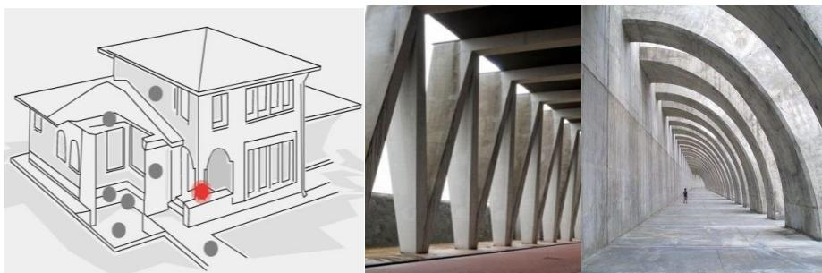
**Stalpii** din beton armat reprezinta elemente verticale structurale ce realizeaza structura de rezistenta a unei constructii de zidarie sau a uneia in cadre cu pereti din beton armat. Stalpul unei case poate avea diverse sectiuni, in functie de tipul structurii, tehnologia de executie si sarcinile pe care le preia, in urca calculelor efectuate de inginerul structurist.
