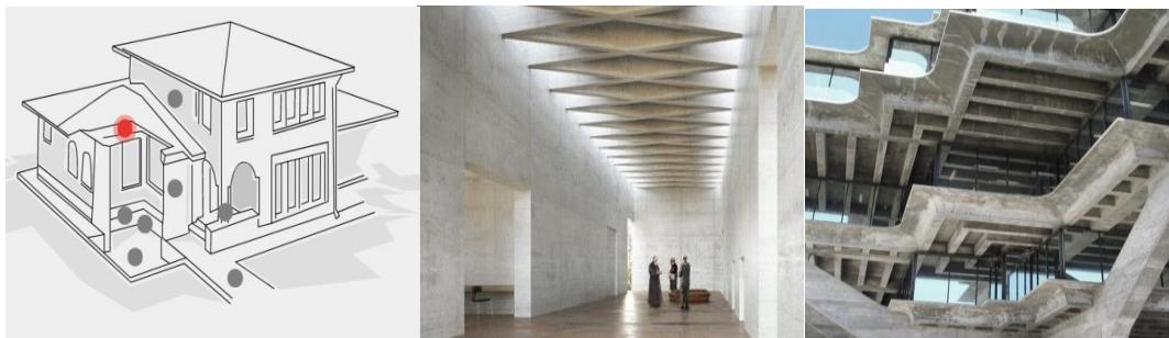
**6.1. Planseele** sunt elemente de constructii orizontale sau inclinate care indeplinesc rolul de compartimentare a cladirilor pe verticala, iar la cladirile cu acoperis terasa, planseul ultimului nivel este totodata elementul care inchide constructia la partea superioara. Rezemarea planseelor se face, in functie de dimensiunea lor si solutia aleasa de proiectant, pe:
