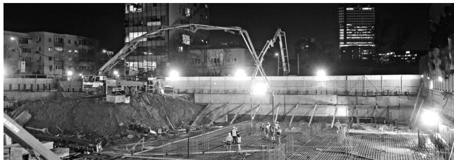
**2.2.1. Definitie:** Betonul cu caldura redusa de hidratare include in componitie un ciment de tip LH (cu caldura de hidratare redusa), reteta fiind proiectata special pentru a limita temperaturile dezvoltate, in special in elementele masive.
